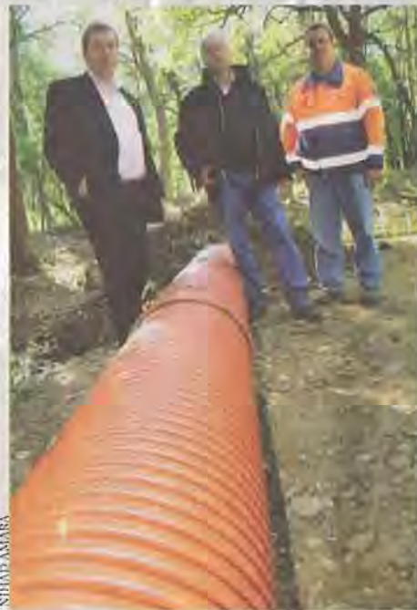
Wasser-Pipeline wurde in Stockerau verlegt
