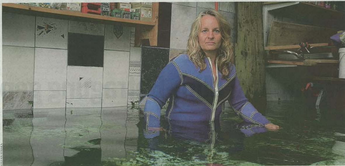
Abgetaucht: Wenn Renate Walker nicht rund um die Uhr pumpen würde, stünde ihr das Wasser nicht nur bis zum Bauch. Schon jetzt geht sie nur mehr im Taucheranzug in den Keller
