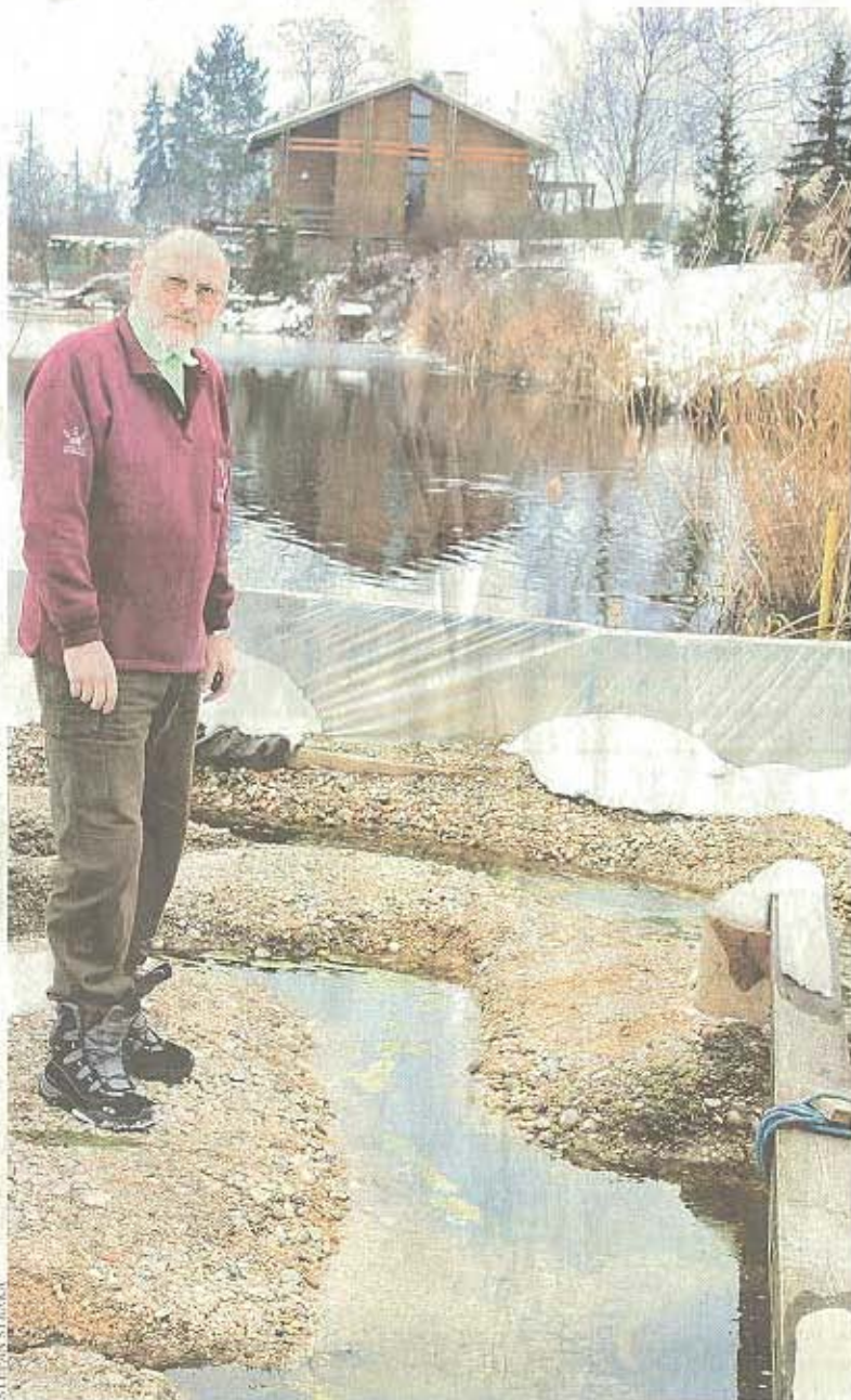
Spielvogel ist mit den Nerven am Ende: „Das Wasser ruiniert die Fundamente“
